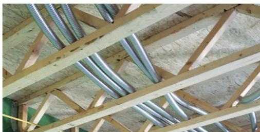
Les solives à plaques ont des bordures tranchantes qui risquent de dénuder des fils. Le filage ci-dessus est protégé par une gaine métallique qui pourrait accroître les chances qu'il se coince sur les plaques. Les solives ajourées TRIFORCE® procurent un espace totalement ouvert permettant d'installer facilement la plomberie, l'électricité et les conduits de ventilation.
