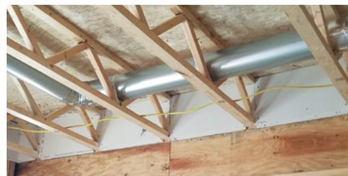
On voit ici un conduit de ventilation de 8 pouces le long d'un mur. Un trou d'une telle taille dans une solive en I aurait assurément été inacceptable à cet endroit puisqu'il aurait sérieusement réduit sa capacité à porter la charge et aurait affaibli la structure.
