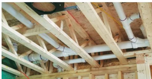
Cette photo montre à quel point il est simple d'utiliser un laser pour assurer une pente adéquate à la plomberie. La tâche aurait été beaucoup plus ardue avec des solives en I; des trous auraient dû être percés de façon très précise afin d'avoir une pente convenable.
